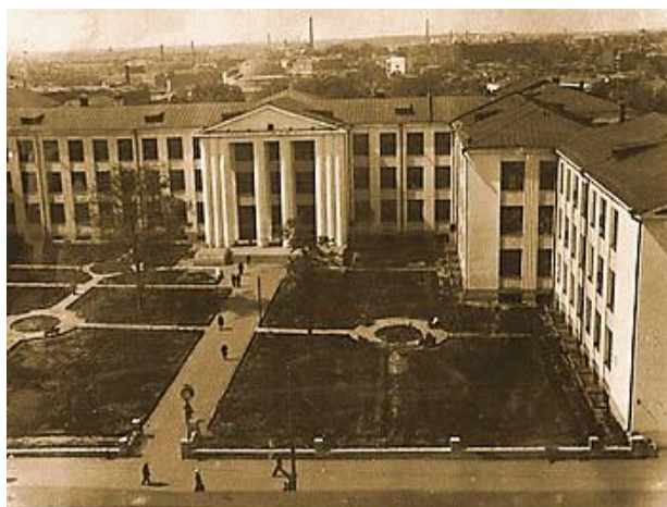
Здание Текстильного института, спроектированное И.А. Фоминым как главный корпус ИВПИ. Сдано в эксплуатацию в 1937 г. Фото 1950-х гг.
